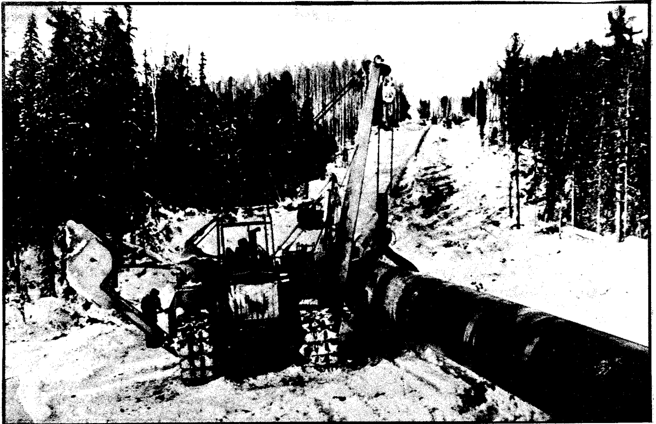
ПРОКЛАДЫВАЮТ НЕФТЕПРОВОД В СИБИРСКОЙ ТАЙГЕ
